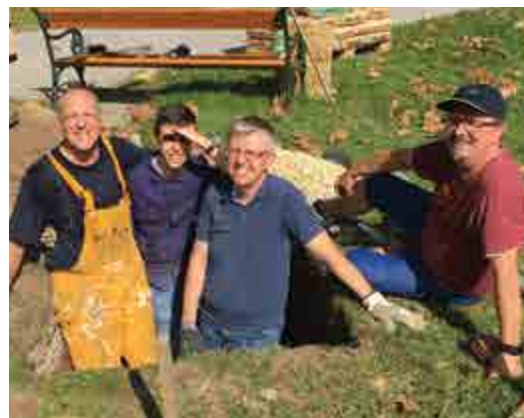
Brüder aus der Gemeinde Wien 2 haben mit vollem Einsatz das Fundament für die kommende Stele vorbereitet
